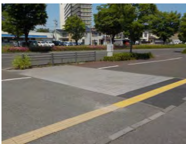
(2)-②-2 歩道舗装を利用 した遺構平面表示
