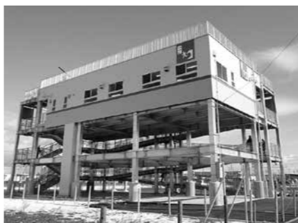
中野五丁目津波避難タワー。津波や漂流物の衝突も考慮した頑強な構造で、寒さから身を守る居室空間も設置
