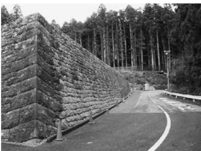
石垣は、伝統工法と一部に現代工法を取り入れた工事により復旧しました
