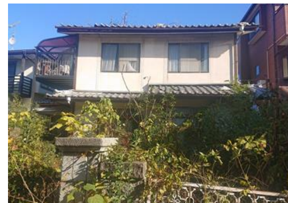
管理不全な空き家の例
