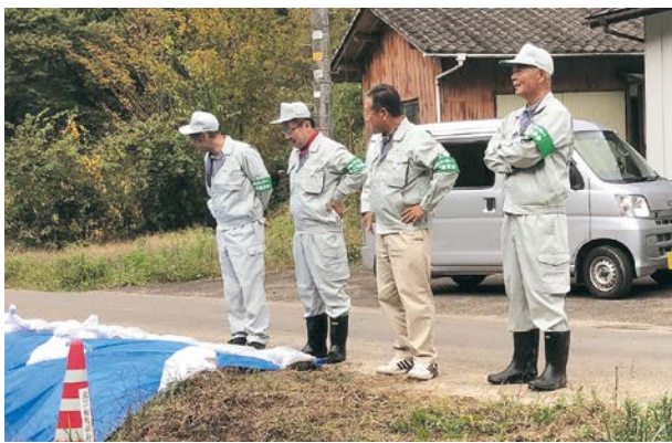
台風によって崩れた水路の状況を確認
