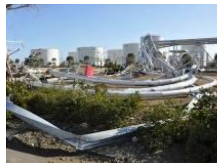
ガス局港工場
