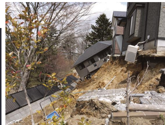
宅地被害(青葉区西花苑)
