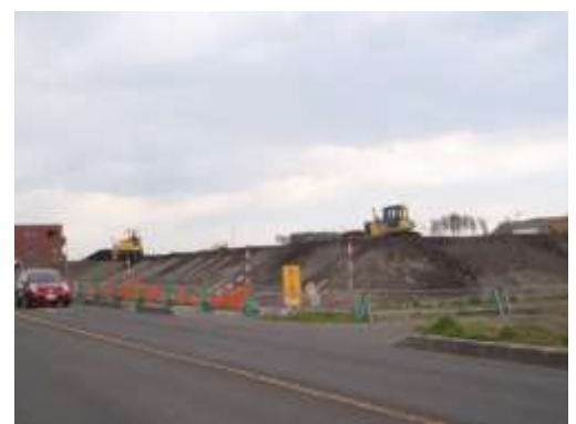
かさ上げ道路の盛土状況 (H26.5.12現在)
