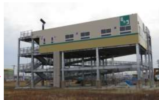
建設中の津波避難タワー(H27.1現在)
