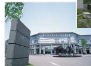
仙台国際センター会議棟
