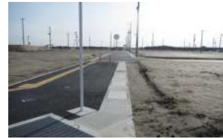
インフラ整備が進む六郷地区 (H27.3撮影)
