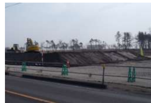
かさ上げ道路の盛土状況(井土工区)
