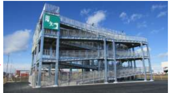
H27.2に竣工した津波避難タワー
