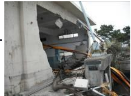
高砂南部排水機場
