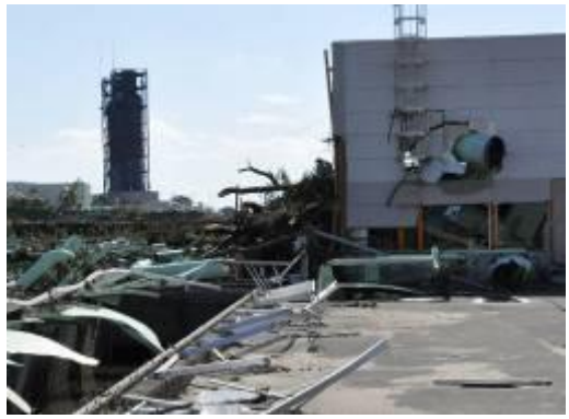
南蒲生浄化センター
