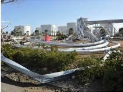
ガス局港工場
