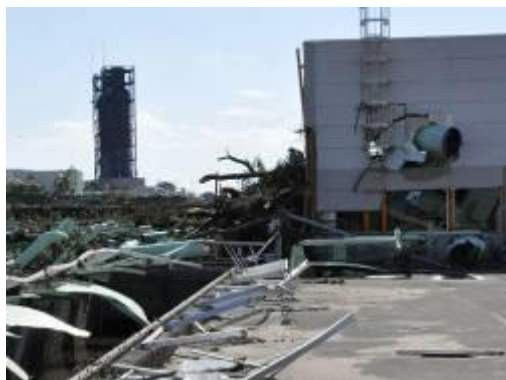
南蒲生浄化センター
