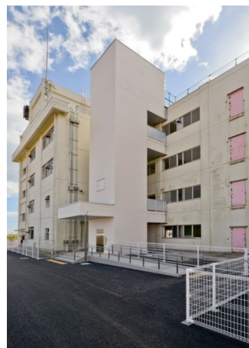
エレベーター棟
