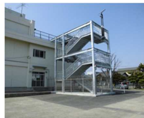
津波避難屋外階段
