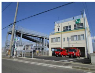
ビル型 (消防団施設併設)
