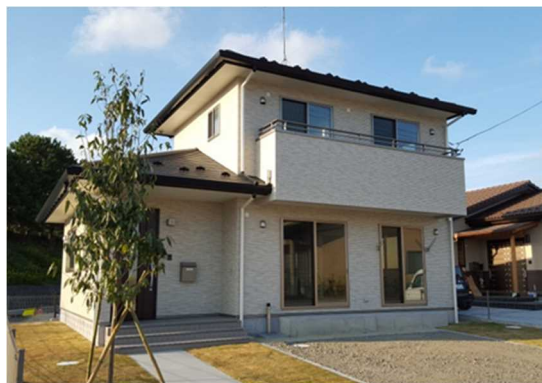
建物全景（七郷地区）
