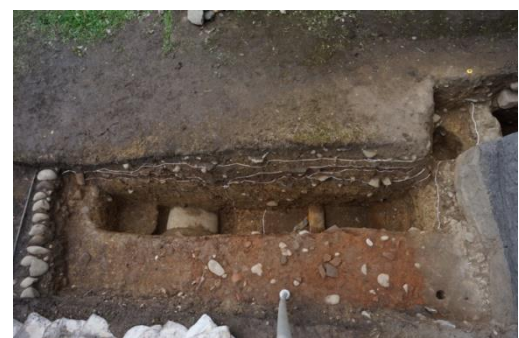
第9図 1区:埋設管設置状況(西から)
