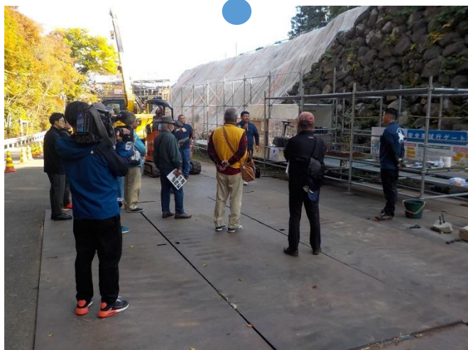
清水建設さん全面協力による、アトラクションブース。実際に施工を担当しているからこそその話を、皆様とても熱心にきいてくださいました。
