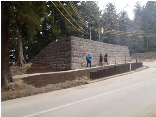
歩道の通行が再開された中門北側石垣
