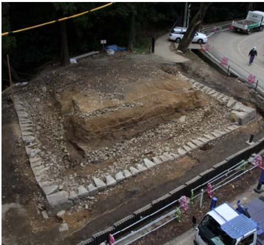
解体された中門北側石垣
