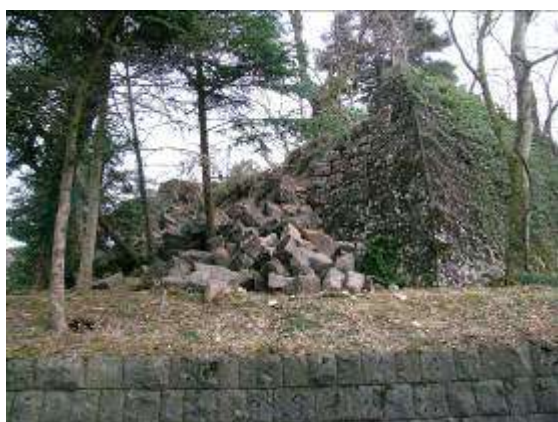
【本丸北西石垣北部北側の被害 (図③)】
