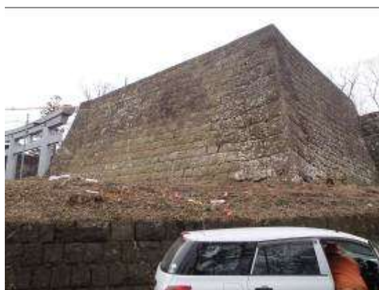
→ 【本丸北西石垣北部北側の復旧状況】
