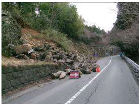
【本丸北西石垣北部南側の被害 (図③)】
