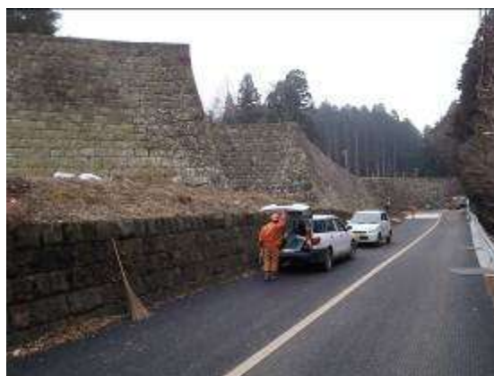
→ 【本丸北西石垣北部南側の復旧状況】
