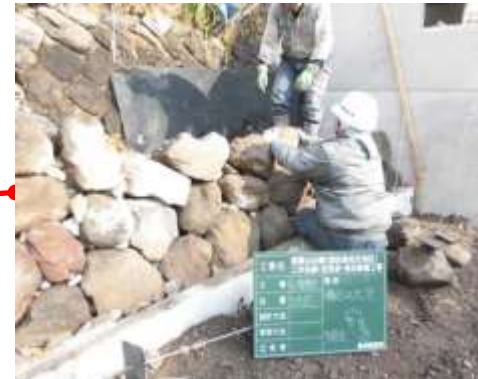
石積(新設割石)
