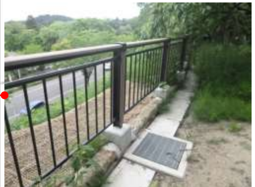
既設階段手摺
