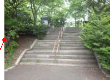
既設階段手摺
