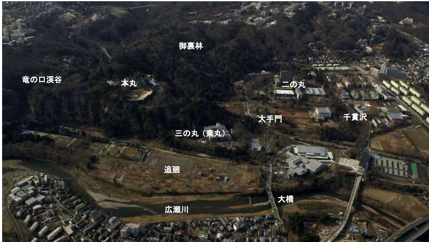
図 1 空撮写真 (東から)
