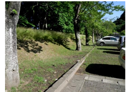
三の丸土塁現況 (北西から)
