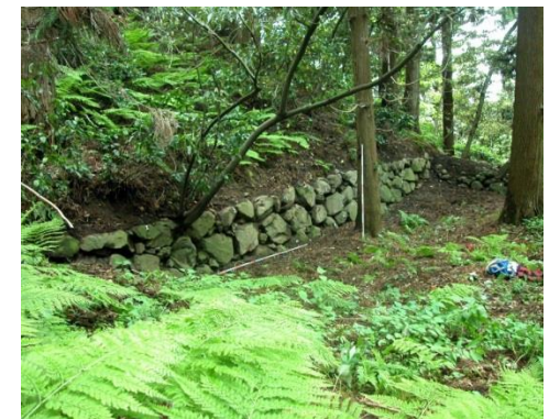
清水門跡北側石垣現況 (南西から)
