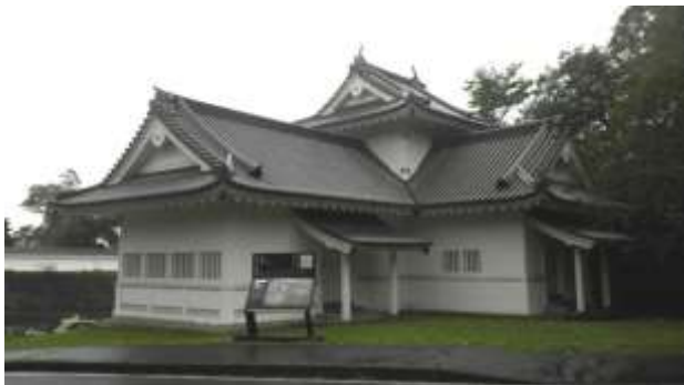
図 3 現況（南西から）
