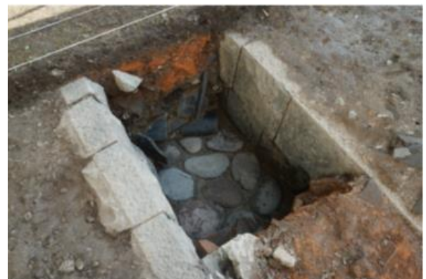
石組側溝の構造 石組を側面とし、底面には扁平な円礫が面的に設置されています。
