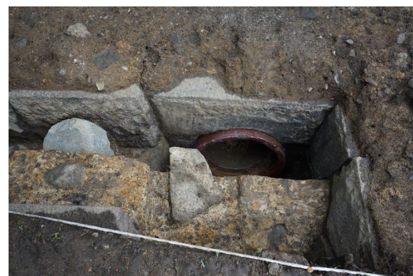
石組側溝と土管の口（北から）
