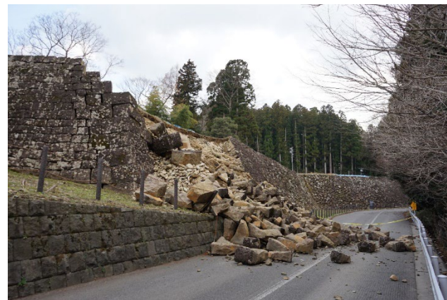
【写真1-2】崩壊した石垣
