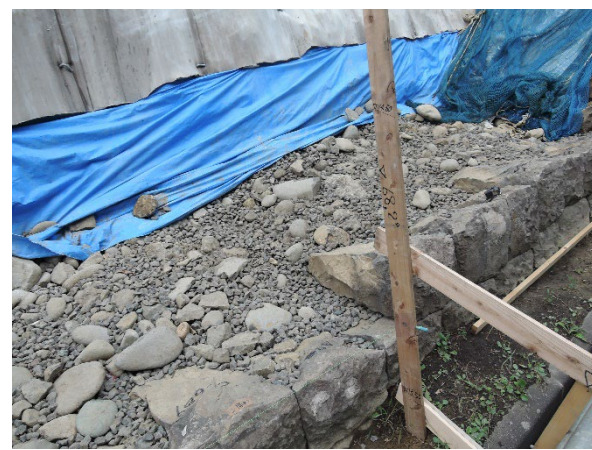
【写真4】被災前測量データを基に設置した丁張
