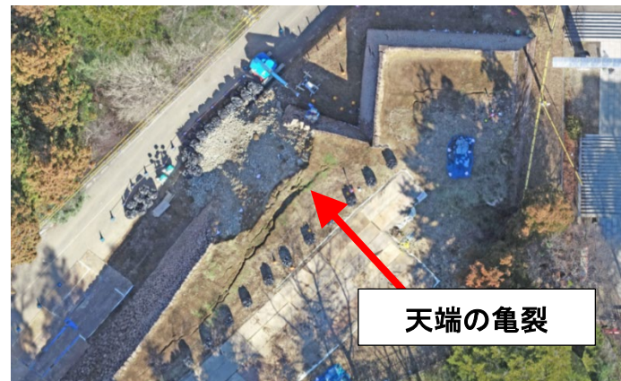
【写真1-1】石垣天端の亀裂
