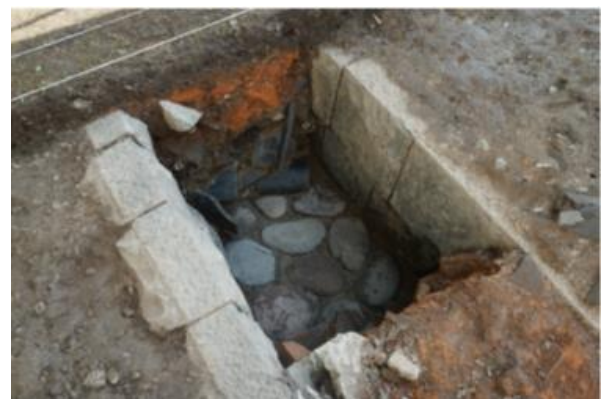
図17 石組側溝の構造
