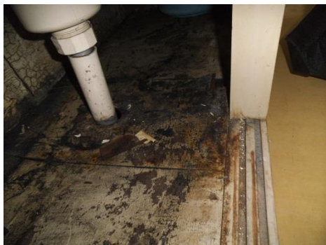
流し台にある排水管の不具合で、水漏れが発生し、周辺が腐食しています。
