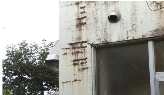
外壁に爆裂が発生しています。こうした場所に近づく時は、破片の落下に注意しましょう。
