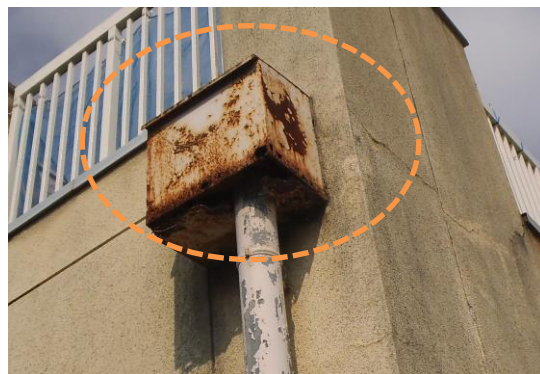
雨桶が腐食し、穴が開いています。さらに腐食が進むと落下の恐れがあります。
