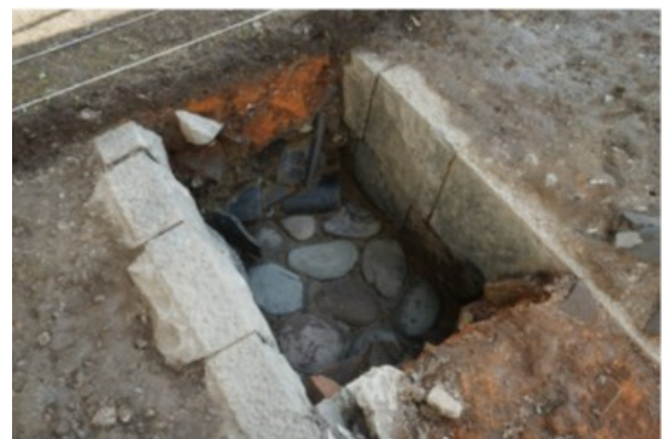
図17 石組側溝の構造
