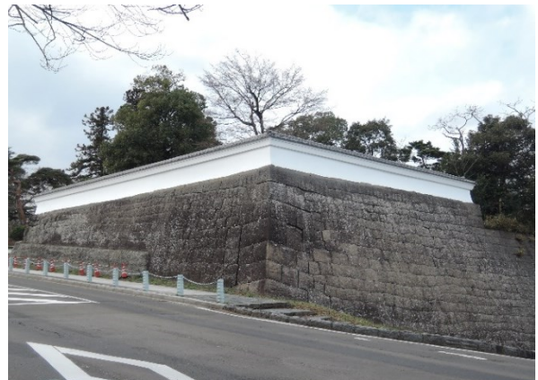
図9 大手門北側土塀
