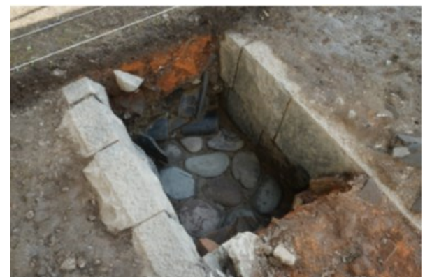
図17 石組側溝の構造
