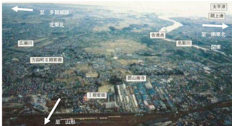
郡山遺跡周辺から太平洋を望む（昭和 62 年撮影）（西から撮影）
