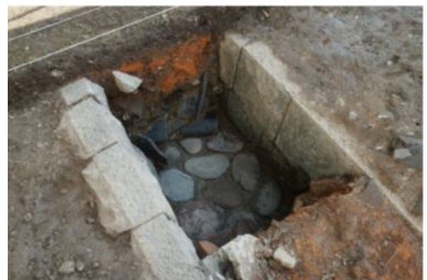
図17 石組側溝の構造
