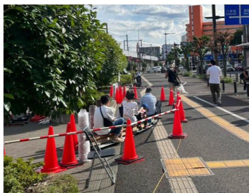
広場を飛び出しミニS Lが道路を走る (仮設点字ブロックにより点字ブロック利用者に配慮)
