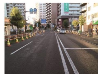
旧国道4号の交通規制(4車線のうち、歩道側2車線を規制)
