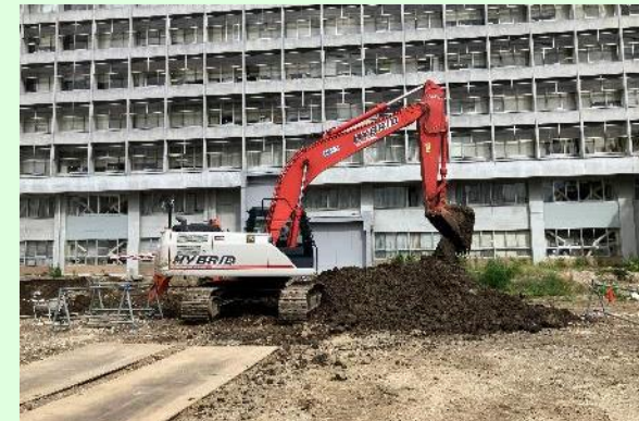
▲埋設物試掘状況
