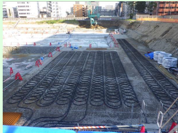
▲地中熱配管工事のイメージ
