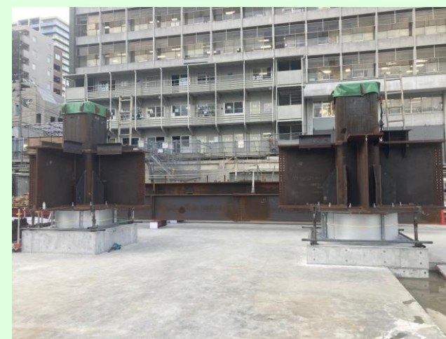
▲免震設置上部の鉄骨
