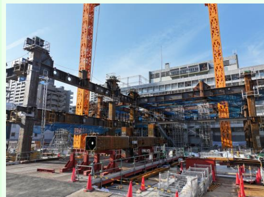
地上鉄骨組立状況
