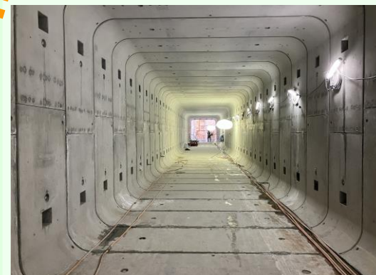
地下連絡通路の内部写真
