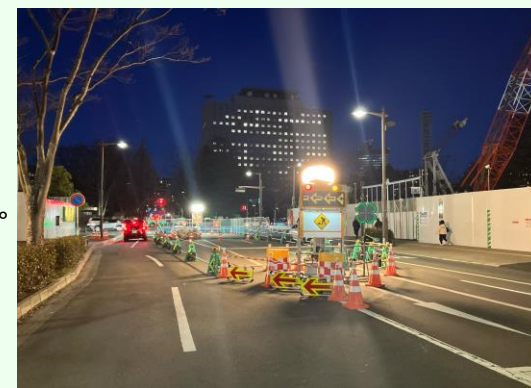
市道表小路線の工事状況
