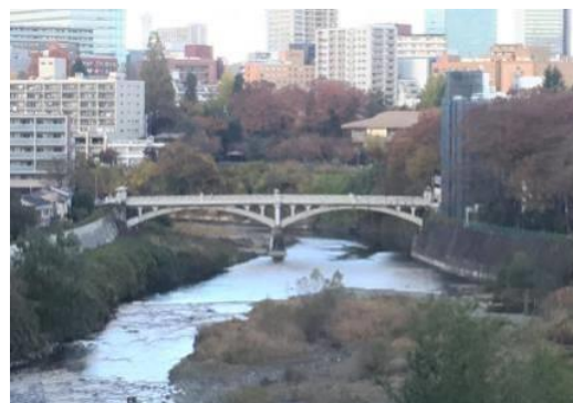
広瀬川にかかる橋りょう(霊屋橋)
