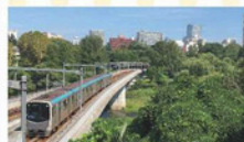
国際センター駅(東1出口)からの眺望
