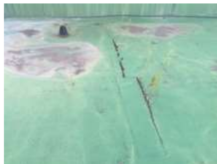
本庁舎屋上防水の状況
