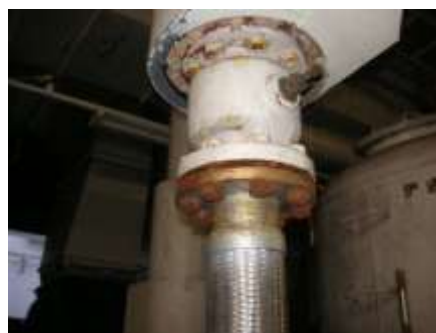
本庁舎機械室 揚水ポンプの状況
