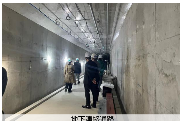
地下連絡通路
