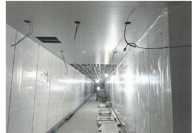
▲地下連絡通路
