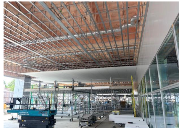
▲ピロティ（車寄せスペース）
