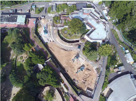
令和7年9月 ガン生態園解体
