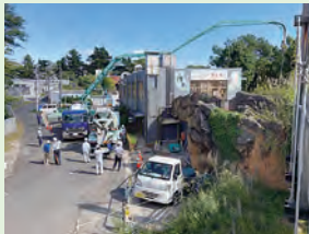
令和7年10月 サイ放飼通路 壁 コンクリート打設
