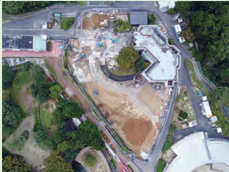
令和7年10月 旧ゴリラ舎、は虫類館解体中
