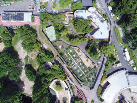
令和7年6月 仮サイ舎改修中
