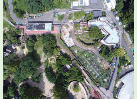
令和7年8月 ひよこの家解体、仮カバ舎改修中
