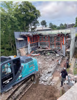
令和7年8月 ひよこの家 解体中
