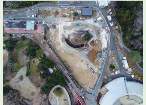
令和7年12月 仮カバ舎完成、カバ引越し
