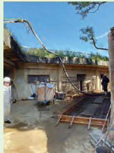
旧ゴリラ舎・は虫類館 解体中
