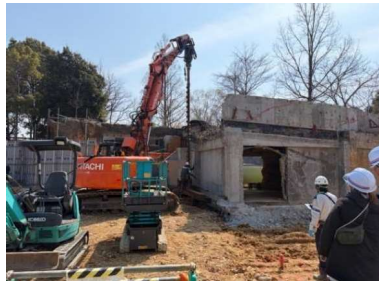
← 親杭作業中 （穴あけ）
