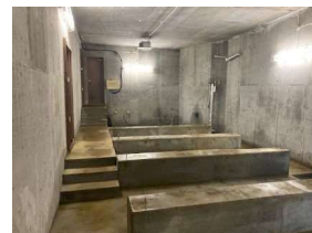
【改修前】受水槽撤去後の室内
