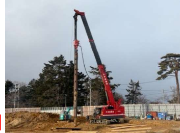
← 杭抜き用の重機
