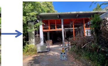
外壁パネル撤去
