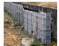
仮囲い（平原動物舎裏側）
