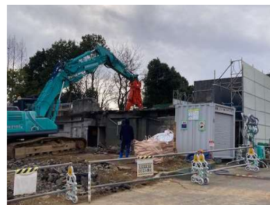
サイカバ舎は、は虫類館側から解体していきます。
