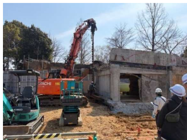
← 親杭作業中 （穴あけ）
