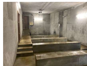
【改修前】受水槽撤去後の室内
