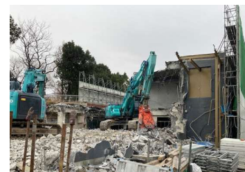
← 左の写真 解体が始まりました。 壁を倒しています。
