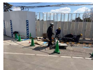
地中化作業「掘削 → 電線用配管を敷設 → 埋め戻し」の繰り返し
