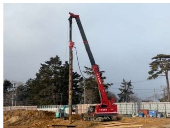
← 杭抜き用の重機
