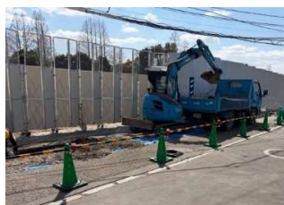
地中化作業「掘削 → 電線用配管を敷設 → 埋め戻し」の繰り返し
