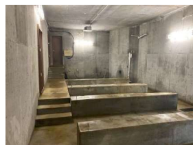
【改修前】受水槽撤去後の室内
