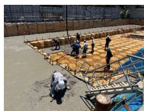
捨てコンクリート打設
