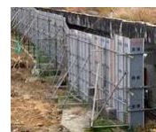
仮囲い（平原動物舎裏側）
