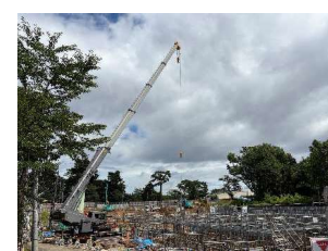
クレーン（高さ約40m）
