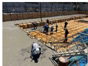
捨てコンクリート打設
