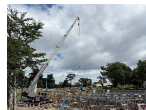
クレーン（高さ約40m）
