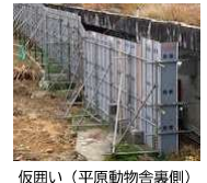
仮囲い（平原動物舎裏側）
