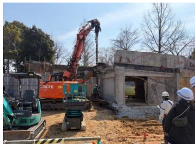
← 親杭作業中 （穴あけ）
