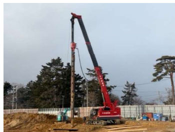
← 杭抜き用の重機
