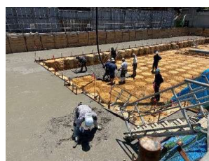
捨てコンクリート打設
