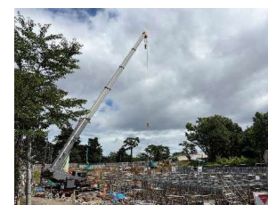
クレーン（高さ約40m）
