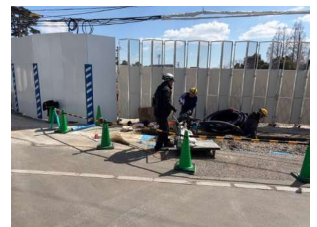
地中化作業「掘削 → 電線用配管を敷設 → 埋め戻し」の繰り返し
