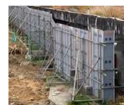
仮囲い（平原動物舎裏側）
