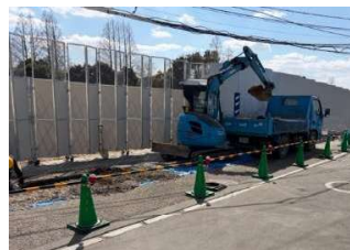
地中化作業「掘削 → 電線用配管を敷設 → 埋め戻し」の繰り返し
