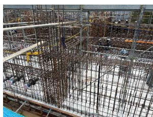
床コンクリート打設後
